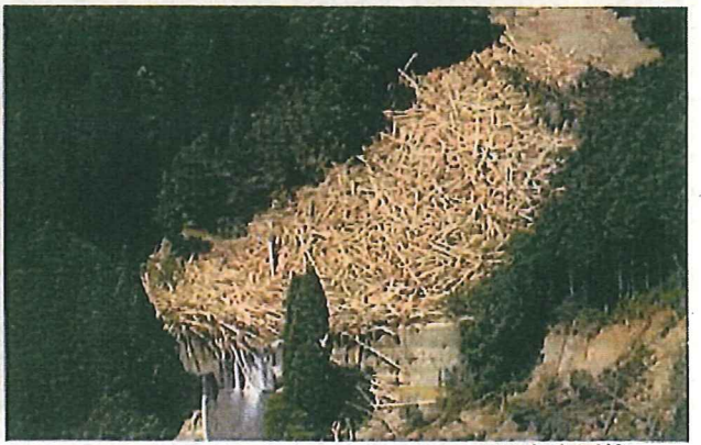
砂防堰堤による流木の捕捉状況(妙見川) みょうけんがわ
